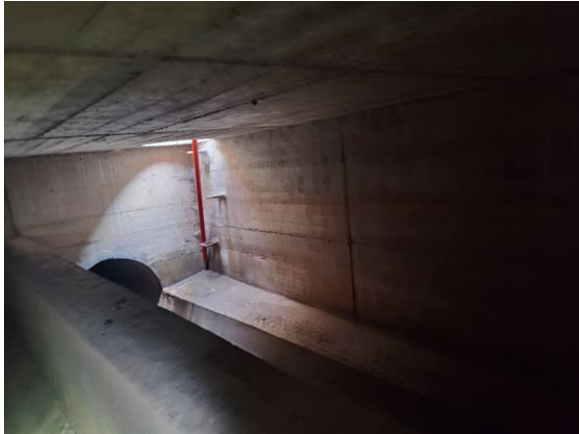
Abb. 26 und Abb. 27:: Beckenüberlauf / Wehrschwelle
