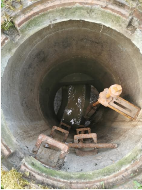
Abb. 31: Drosselschieber SRK 2
