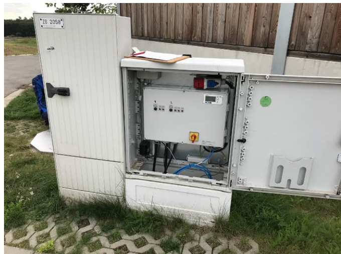
Abb. 46: Schaltschrank Pumpwerk 3
