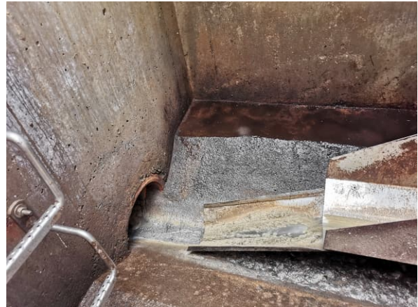
Abb. 17: Waagedrossel RÜB 5 - Ablauf
