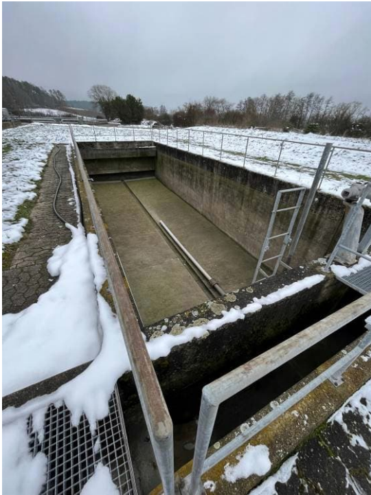
Abb. 3: Regenüberlaufbecken V = 167 \text{ m}^3
