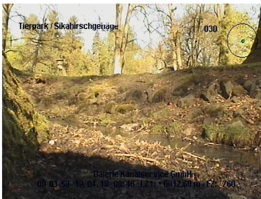
Abb. 36: Auslauf SRK 3 Am Brunnhölzlein (Blick in Fließrichtung, aus TV-Befahrung)
