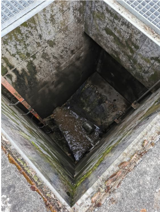
Abb. 6 Drosselschieber RÜB 3 Weitramsdorf
