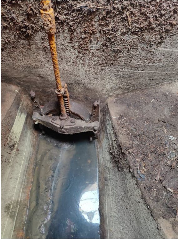
Abb. 40: Drosselschieber SRK 4
